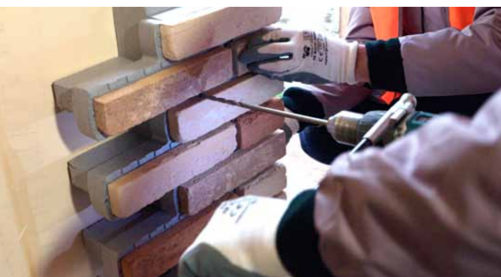
La posa di un angolare Terracoat
