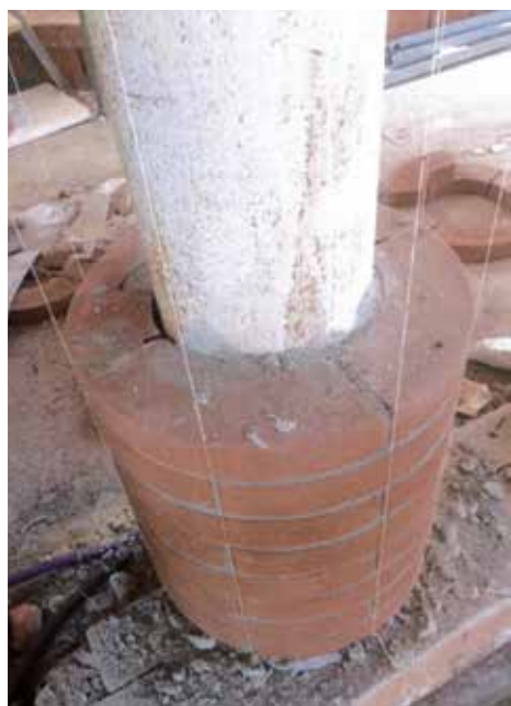
Dettaglio del completamento di una colonna con il rivestimento in mattoni curvi
