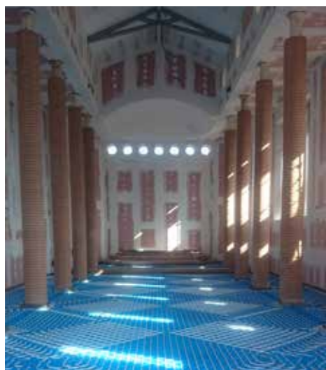
Dettaglio del completamento di una colonna con il rivestimento in mattoni curvi
