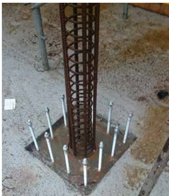
L'armatura di una colonna prima del getto in calcestruzzo. A destra, particolare costruttivo di una colonna interna
